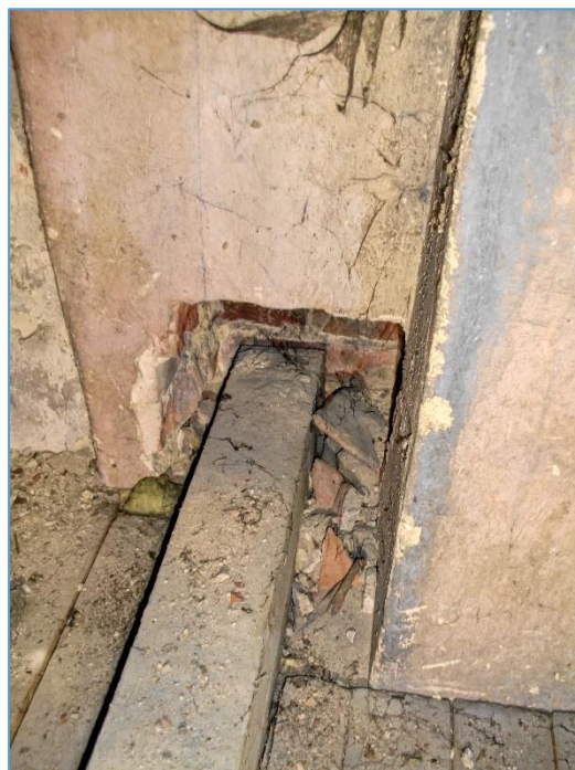
Obr.č. 6 – PERFEKTNĚ ULOŽENÁ ZHLAVÍ VAZNÍCH TRÁMŮ
