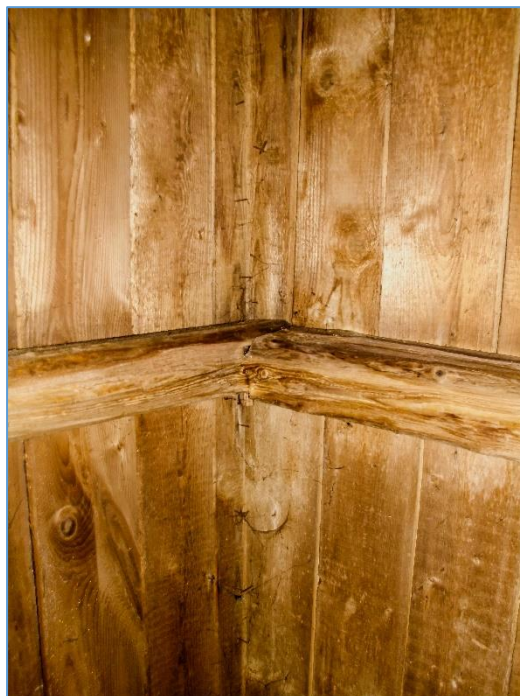
Obr.č. 4 – KROKVE V HŘEBENU SPOJENY „NA OSTŘIH“
