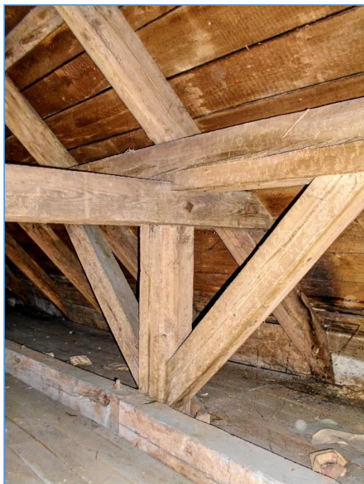
Obr.č. 7 – KONSTRUKČNÍ SPOJ KROVU
