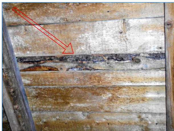
Obr.č. 5 – LOKÁLNĚ NEODKORNĚNÉ STŘEŠNÍ PODBITÍ (ZATÍM BEZ NÁZNAKU ČINNOSTI DŘ. HMYZU)
